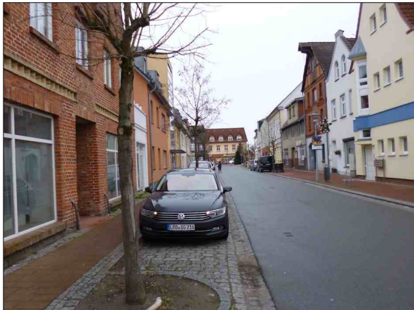
Ortszentrum – Stralsunder Straße: zunehmende Leerstandsentwicklung auf der südlichen Straßenseite
