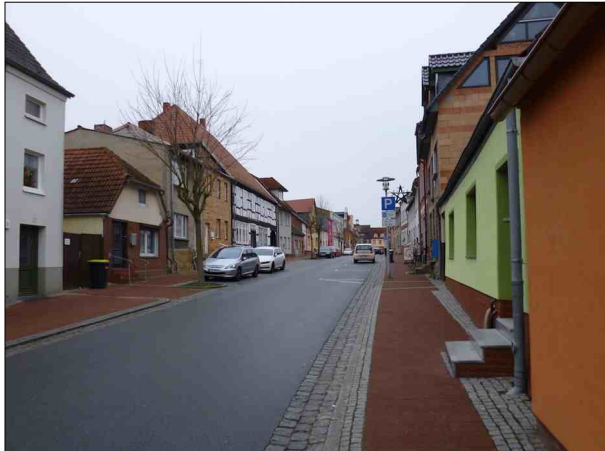
Ortszentrum – Stralsunder Straße: Blick von Osten in Richtung Schillstraße – Zentrumscharakter ist nur noch schwach erkennbar, viele Leerstände
